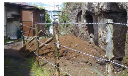
女子棟裏の崖崩れ。崖の一部が崩落し、土砂が堆積する。正門に繋がる薬師坂の崖崩れの様子。
