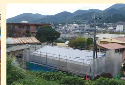
建替えが進む厨房棟。その左側に見えるのが旧厨房棟。(10月撮影)
